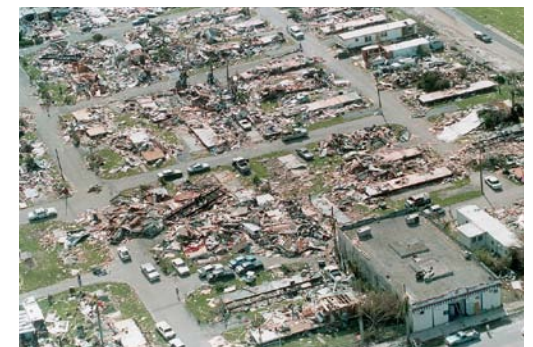
En 1992, les vents de l'ouragan Andrew, de catégorie cinq, ont causé des dommages dévastateurs sur une vaste étendue
