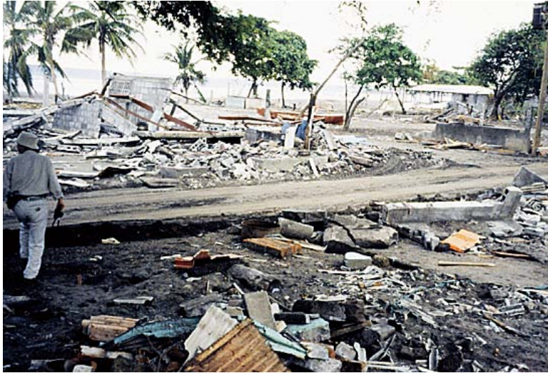
Les dommages suite à un tsunami
