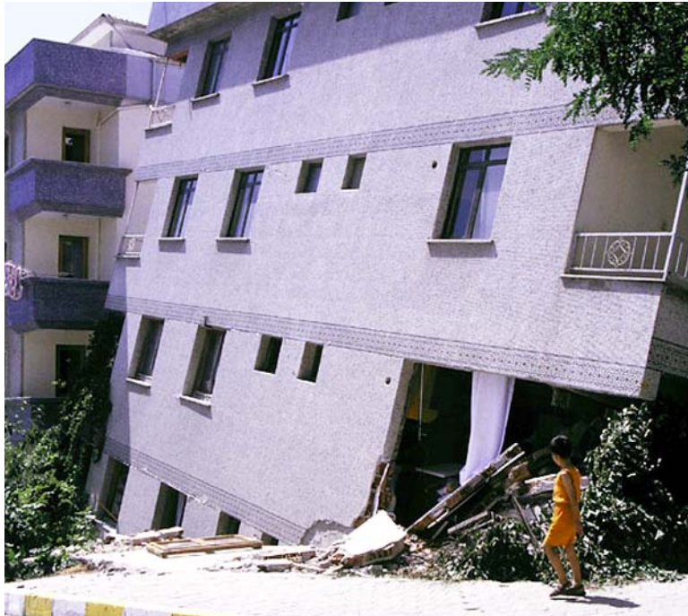
Les tremblements de terre peuvent causer des dommages et même détruire des bâtiments.
