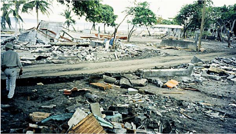
Les dommages suite à un tsunami
