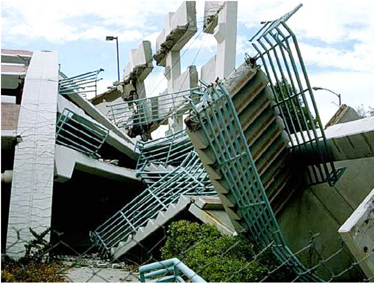
Un tremblement de terre a détruit cet édifice.
